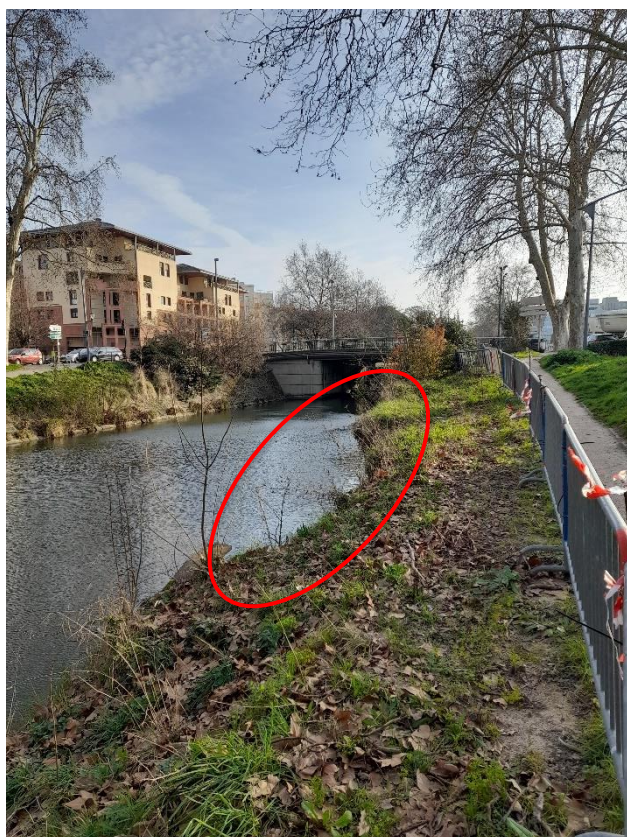
Figure 4 : Photos de l'effondrement de berge
